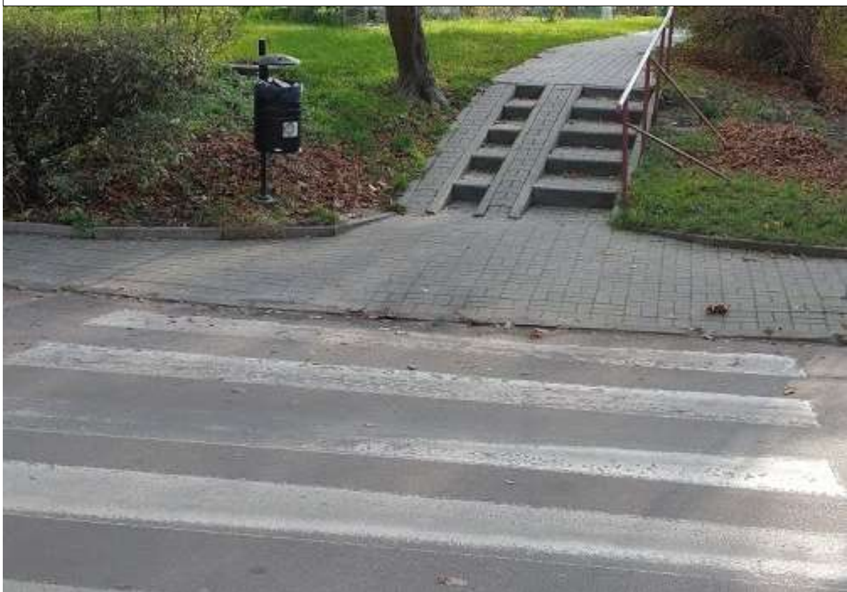
Zdjęcie 8 Schody wybiegające na przejście dla pieszych
