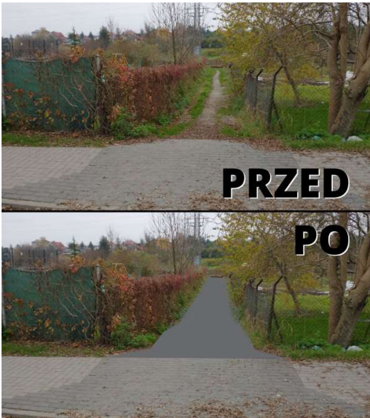
Zdjęcie 11 Utwardzenie istniejących dojazdów do kładek przez rzekę Czarniejówkę.
