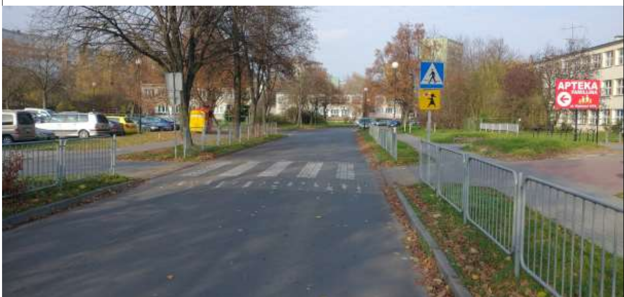
Zdjęcie 3 Przejście w ciągu Alei Młodości przez ul. Radości
