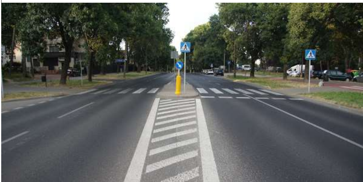
Zdjęcie 9 Przejście z azylem przez ul. Koryznowej
