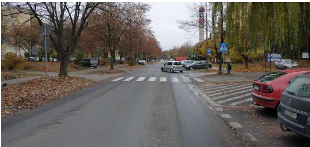
Zdjęcie 8 Przykład bezsensownie wydłużonego przejścia dla pieszych i zachęcania do nielegalnego parkowania przed przejściem dla pieszych
