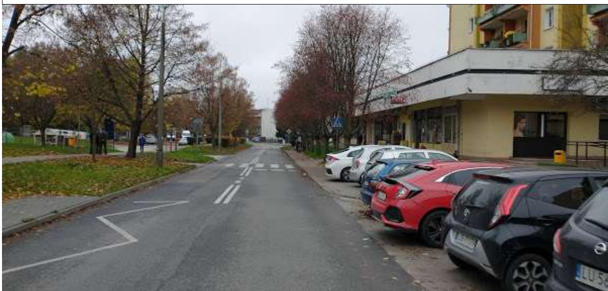
Zdjęcie 11 Ulica Daszyńskiego – brakuje fizycznego uspokojenia ruchu
